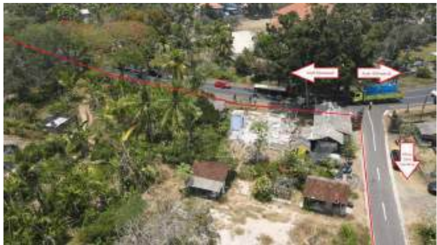
Dokumentasi: Survei Lokasi Lahan Pembangunan RSA Bali
